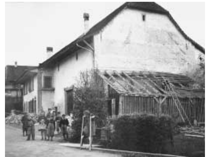
Ansicht des Pfarrhauses von 1550, aus der Zeit, als die 1954 abgebrochene Scheune aus derselben Zeit noch stand (Foto 1954).
